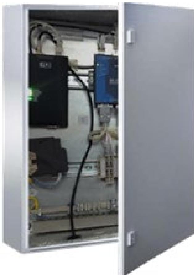
Программно-технический комплекс телемеханики выполнен на аппаратной платформе Российского производства (внесен в реестр Минпромторг) с применением отечественной операционной системы (Alt Linux, ASTRA LINUX) и ПО «Релематика МД» собственной разработки. ПО «Релематика МД» имеет свидетельство о государственной регистрации программы для ЭВМ, сертификат МЭК 61850 и внесено в реестр Российского ПО.
